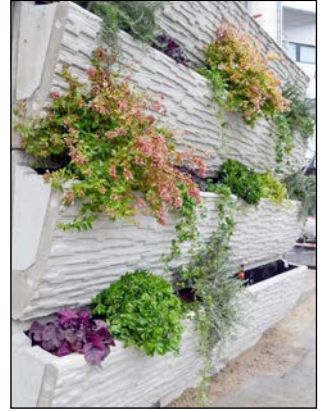
Mur végétalisé par Vegetek.
