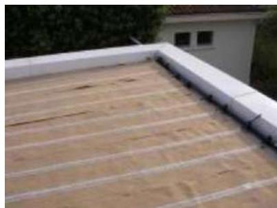
**Figure 3 - Tapis d'irrigation Vertige® installé sur la toiture avec tuyaux d'irrigation intégrés**
